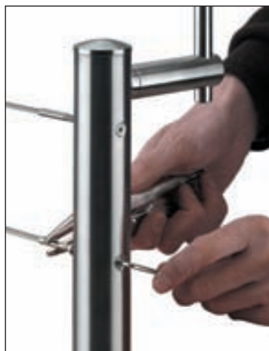
Tension du câble avec une ASS Douille de tension
