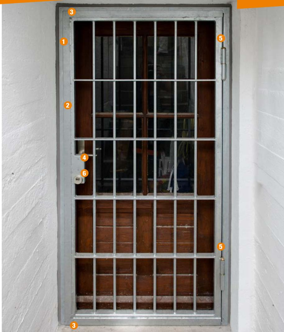
Une porte à grilles de sécurité montée avec barres continues Ø18 mm.
